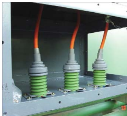
容量性カプラーの取り付け例
