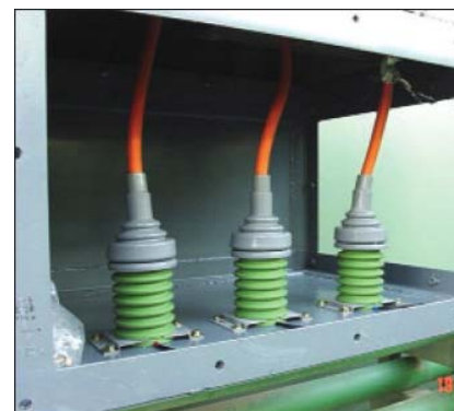
容量性カプラーの取り付け例
